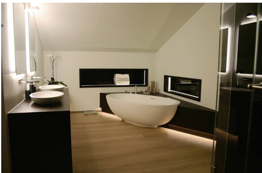
LED-Leuchtstreifen mit 24 V erlauben ausgefallene Beleuchtungskonzepte. Die Streifen können auch auf Holz montiert werden und sie lassen sich zudem einfach dimmen.
